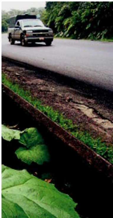
Dos kilómetros antes de llegar al túnel Zurquí, una zona de mucha neblina, no hay señalización.
